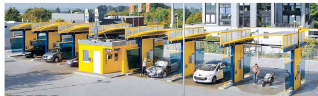
Staalbouw design: De flexibele oplossing met uitgebreide keuze wat betreft kleur, dakvormen en scheidingswanden (hier zaagtanddak).
